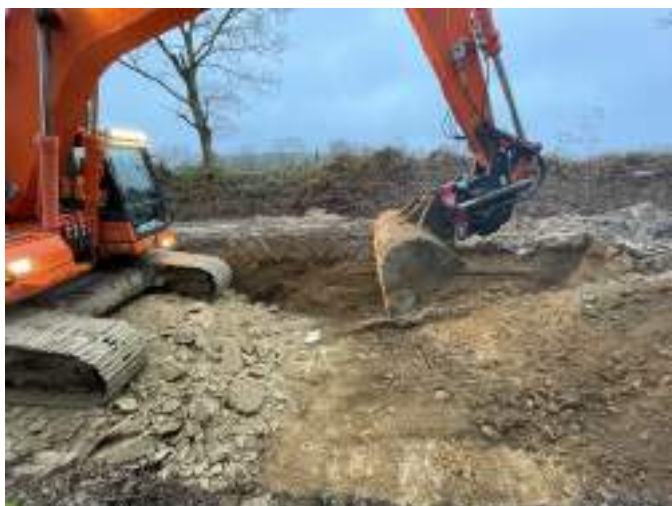
Excavation des fonds de fouille pour les fondations
