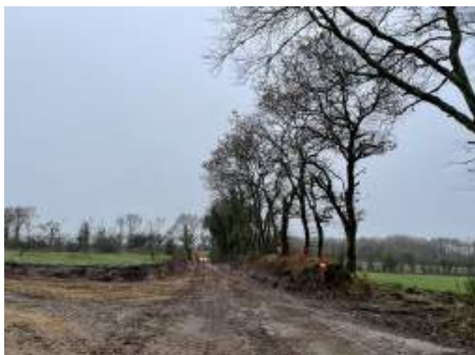
Chemins d'accès décapés
