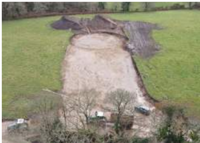
Décapage et terrassement d'une plateforme d'éolienne
