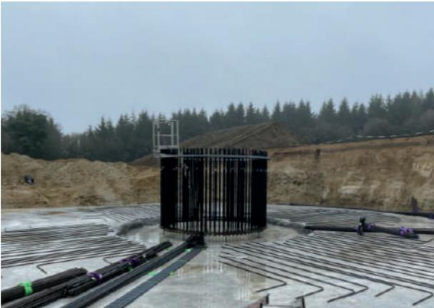
Montage de la cage d'ancrage et ferrillage
